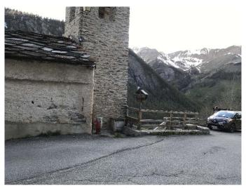
être été doublés si l'édification du bâtiment a été construit à deux époques différente. Il faudrait faire une investigation sur la toiture à l'aide d'un échafaudage ou d'une nacelle. De cette position, il serait également nécessaire de voir comment est réalisé le plancher du clocher.
