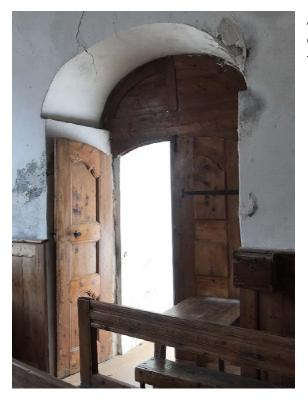
A l'entrée de la salle, à la verticale de la liaison entre le corps de batiment principal et de son clocher, des fissures sont relativement importantes
